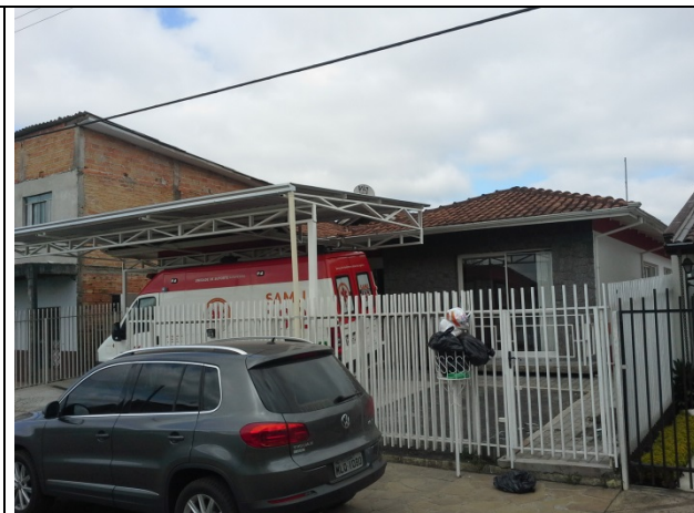
Foto17: Visita para verificação de itens de manutenção pós obra – BASE CAÇADOR
