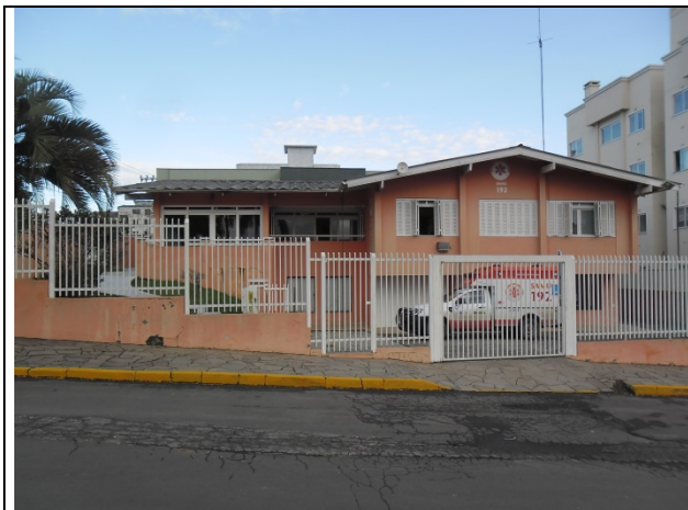
Foto10: Visita Técnica e Cadastramento de base existente – BASE LAGES
