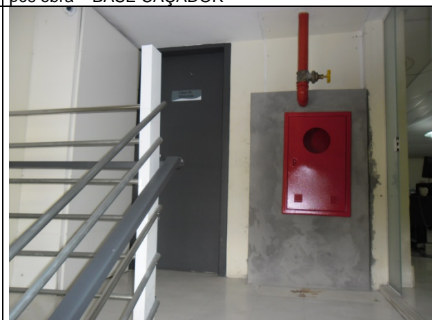
Foto17: Acompanhamento de serviços de adequação de Sistema Preventivo – SEDE ADM FLORIANOPOLIS
