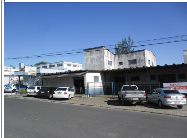
Foto14: Visita Técnica para cadastramento de nova base – Imóvel CRICIUMA
