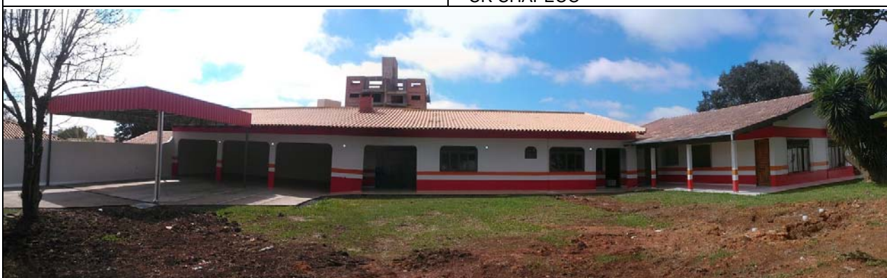
Foto7: Finalização Readequação de Obra – BASE CANOINHAS
