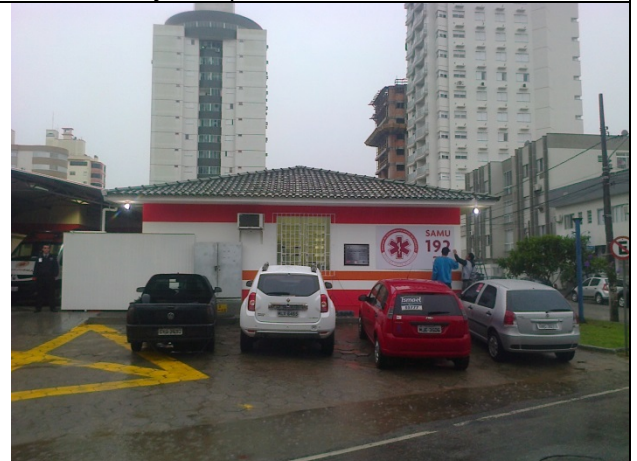
Foto4: Colocação de placa externa – BASE TUBARÃO
