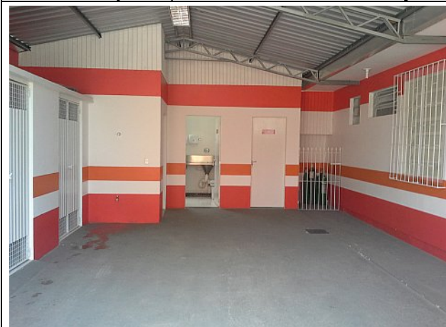
Foto3: Finalização de readequação da BASE TUBARÃO
