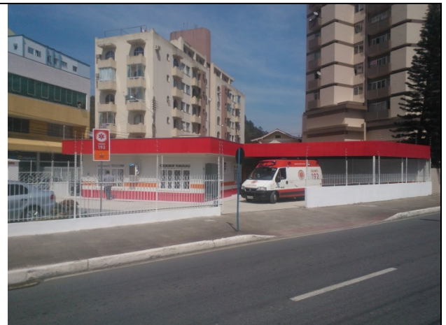
Foto2: Colocação de placa externa – BASE ITAJAÍ
