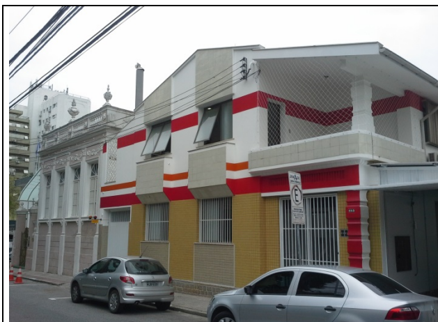
Foto5: Finalização de Obra – BASE FLORIANÓPOLIS
